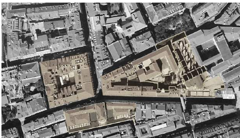
Fig. 19 _ Quarteirões danificados durante o Incêndio do Chiado.
