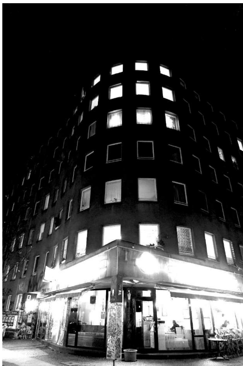
Fig. 46 _ Esquina do edifício de habitação Bonjour Tristesse, Álvaro Siza Vieira.
